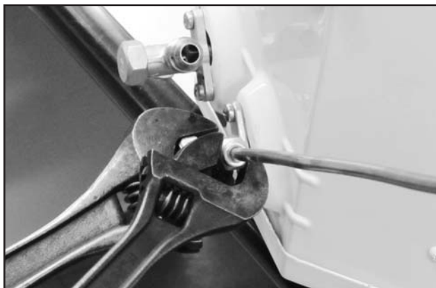
FIG. 31 - FIXAÇÃO DA PORCA
