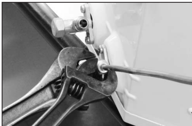
FIG. 31 - FIXAÇÃO DA PORCA
