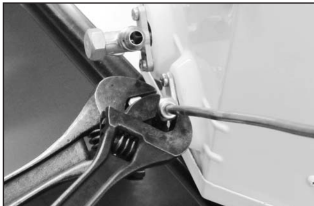
FIG. 25 - FIXAÇÃO DA PORCA
